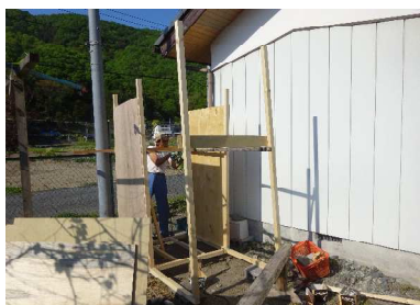
野外トイレ着工2
