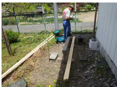
屋外トイレの着工1
